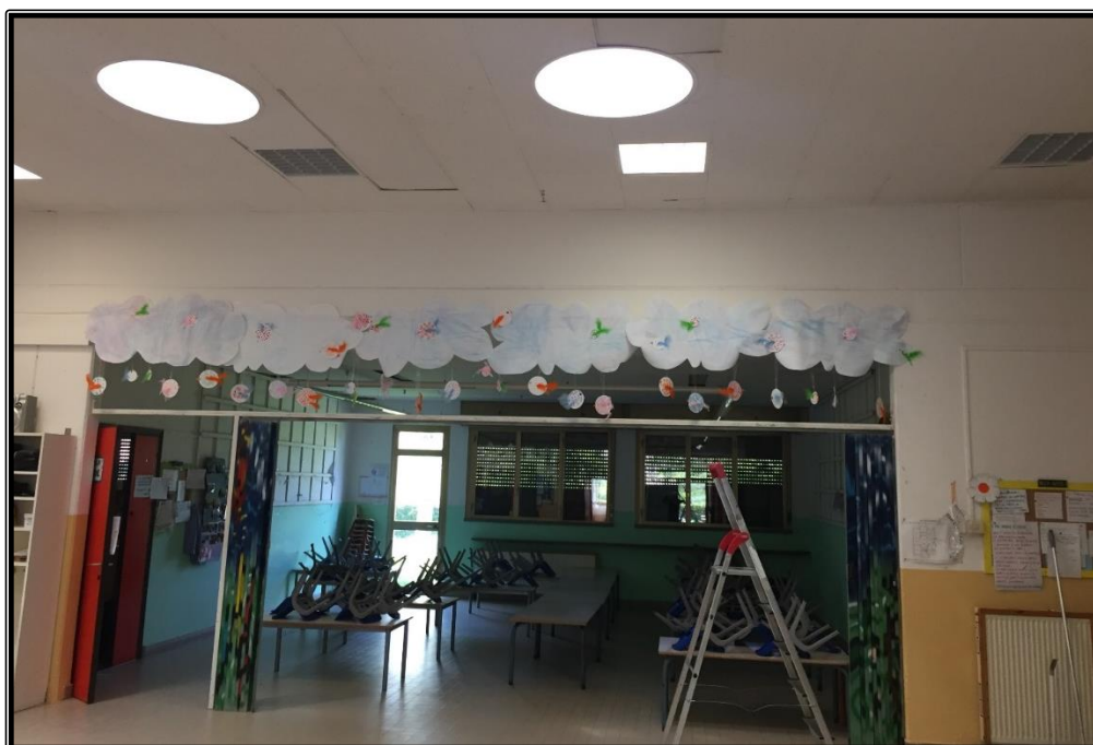
Figura 2 - ambiente a doppia altezza con fori illuminanti nei pannelli di copertura
