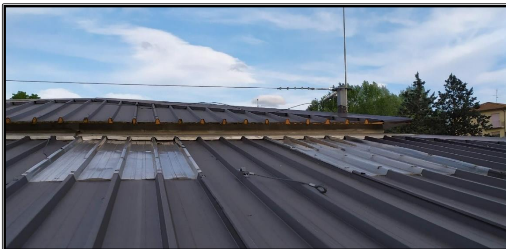
Figura 3 - particolare nuova copertura in lamierino coibentato
